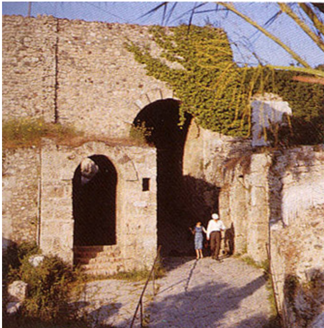
Stadsmuren i Pompeji med porten mot havet, Porta Marina . Till vänster ingång för fotgängare, till höger för vagnar.
